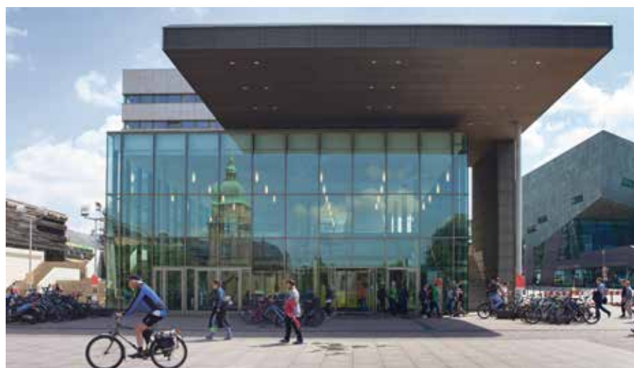
Das Eingangsgebäude Karo 5 der TU Darmstadt am Karolinenplatz. In der Glasfassade spiegelt sich das Hessische Landesmuseum Darmstadt. Foto: Jan-Christoph Hartung
